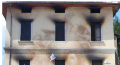
Cevo: una parte dell'opera realizzata da Eron
