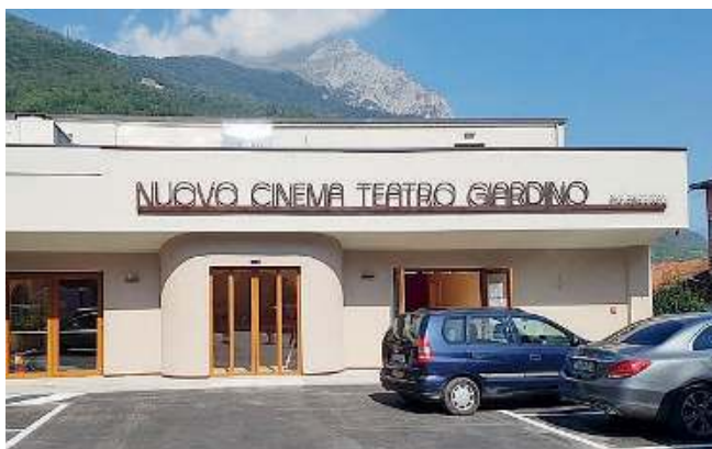
L'esterno. Così si presenta oggi l'ingresso
